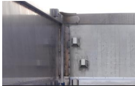
Mulde mit Aufstieg innen an der Stirnwand
